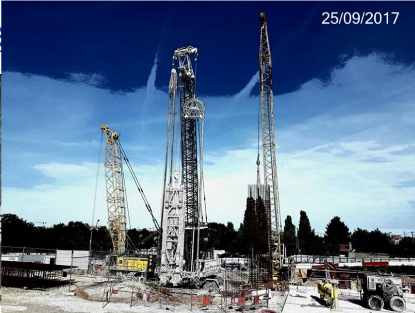
Travaux puits d'entrée du Plateau à proximité du SMR
