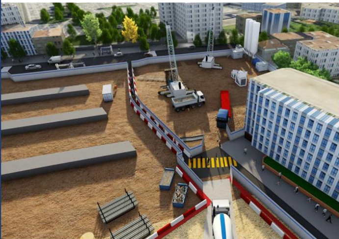
Cheminement actuel sur l'avenue Eyrolles:
