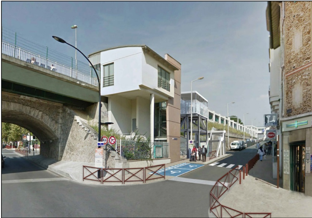
Accès provisoire vu depuis l'avenue Carnot
